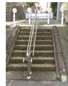
⑫師岡町 手すり&amp;車止め設置
