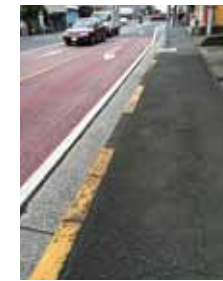
⑮小机町 歩道整備
