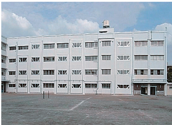
耐震化工事が完了した中学校校舎
