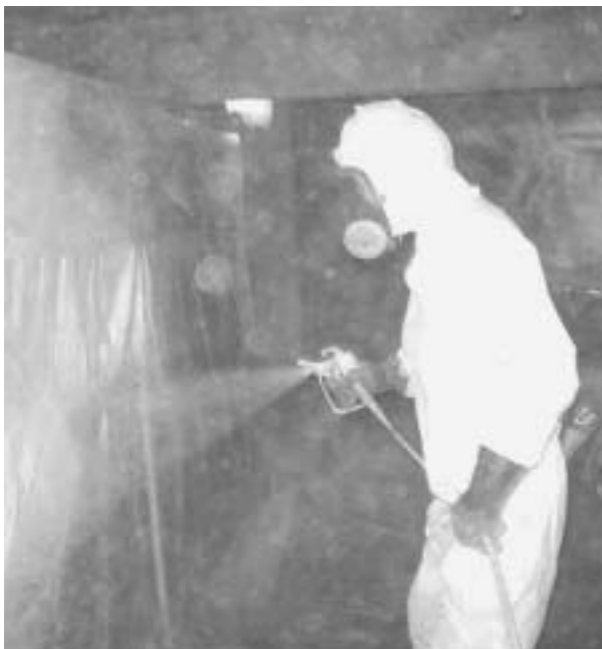
建設業労働災害防止協会の「建築物の解体等工事における石綿粉じんへのばく露防止マニュアル」より引用
