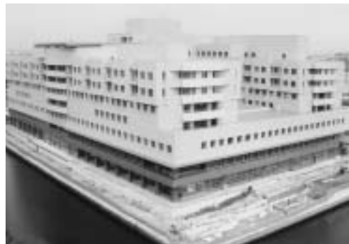
工事が進む新港湾病院
