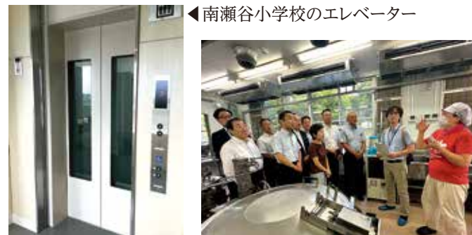
南瀬谷小学校のエレベーター
